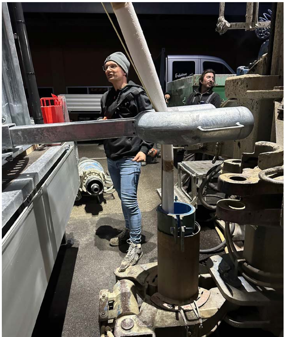
Simon Bernath ist Geschäftsführer des Textilbetriebs. Als Bauingenieur begleitet er Projekte persönlich vor Ort. Hier wird die textile Erdsonde mit eigens konstruierten Geräten ins Bohrloch abgesenkt.
