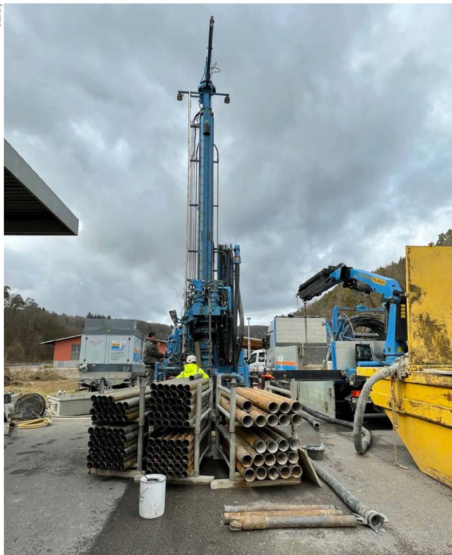
Idealerweise führen Bohrungen für Erdsonden bis in Tiefen mit wasserführenden Schichten.
